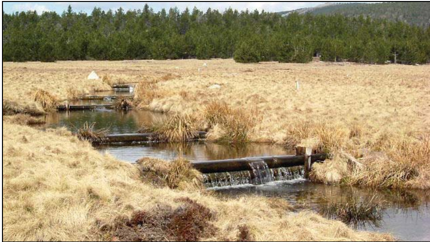
Photo 2 - Série de barrages-seuils dans la partie amont de la Plaine de la Sénégrière.
