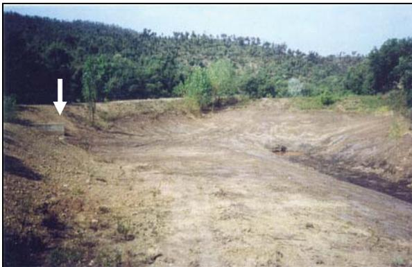
Photo 8 - La retenue du Gageai 1 après curage, en automne 1992 ; le déversoir (flèche) n'est pas très haut par rapport au fond de la retenue.
